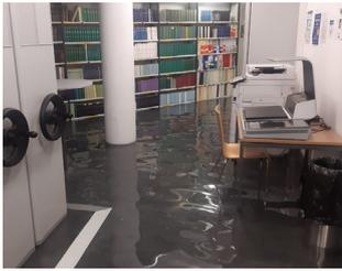
Ende Juni 2021 war im Gebäude der FB ein Ventil der Hauptwasserzuleitung geplatzt. Da das gesamte 2. Untergeschoss unter Wasser gestanden hatte, mussten alle Bücher aus dem Geschoß ausgelagert werden.
