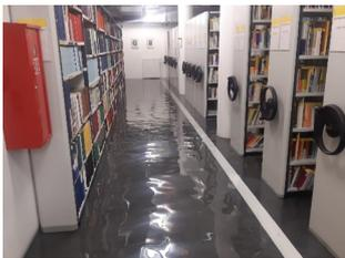
Sämtliche Regalanlagen – insgesamt 4.000 Laufmeter – mussten abgebaut, die Podestböden entsorgt und der Bestandsboden an mehreren Stellen geöffnet werden, um die Dämmung trockenulegen. Die Trocknung mittels Entfeuchtungsgeräten dauerte länger als erwartet, mit den eigentlichen Umbauarbeiten konnte erst im Juni 2022 begonnen werden.
