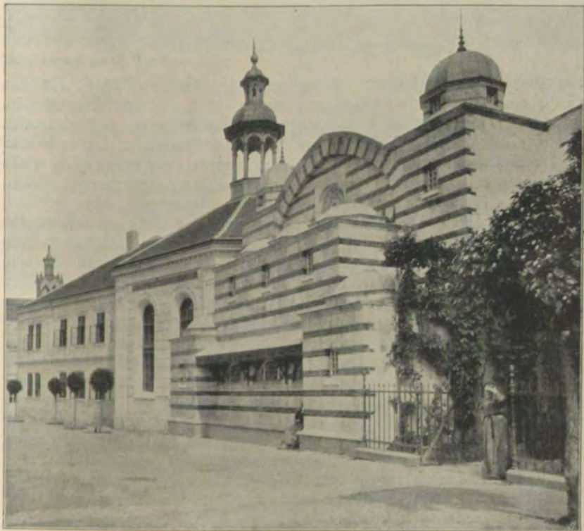
Façade des „Hamam“-Bades.
